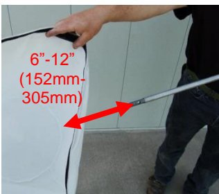
MÅ KUN RENSSES LET MED KOMPRIMERET LUFT UDFRA OG IND. HOLD DYSEN 15-30 CM FRA STOFFET
